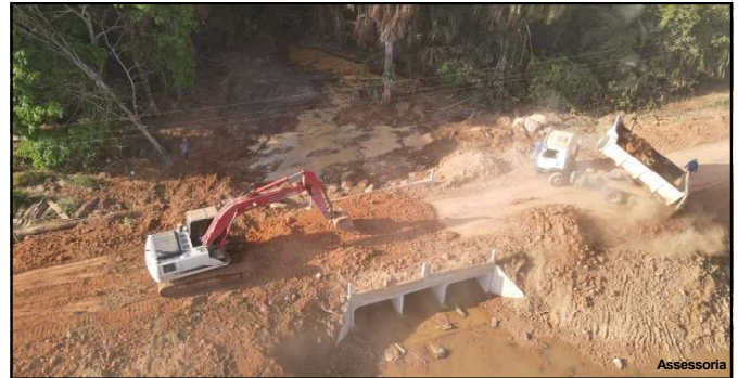
Obra executada pela Secretaria de Infraestrutura de Alta Floresta
